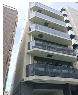
スカイグランデ市川 (2022年8月竣工)
