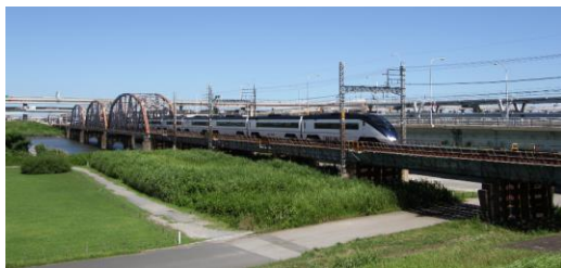
本線荒川橋梁（京成関屋～堀切菖蒲園間）
